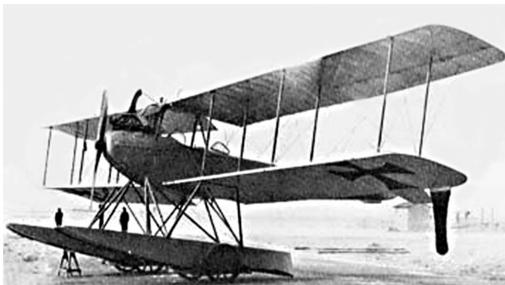
Ганса-Бранденбург НВ (Hansa-Brandenburg NW), разведывательный гидросамолет 1915 г. (компания «Ганза унд Бранденбургише Флюгцейтверке», Германия)
