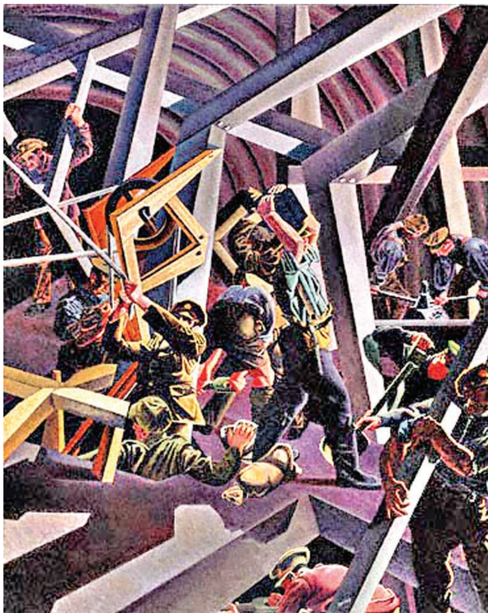
Д. Болберг. Канадские саперы за работой. 1919. Оттава. Национальная галерея Канады
