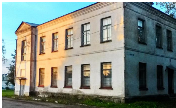
Здание Ярославско-Костромской епархии, на втором этаже которой паломнический центр
