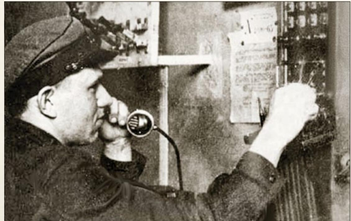
Соединение абонентов на оконечной станции ВЧ-связи. 1937 г.
