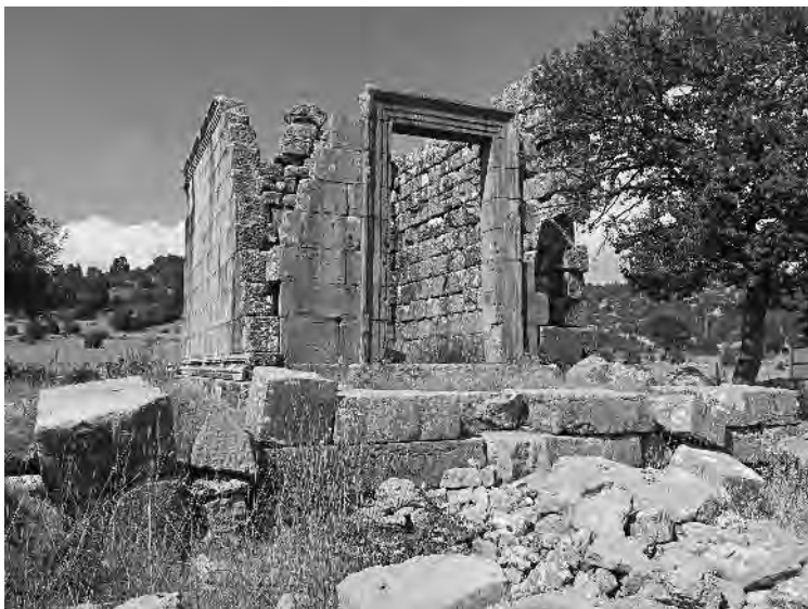
Рис. 1. Адады. Храм Императоров, вид с юго-запада. Фото автора
